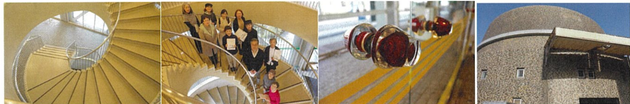
上り下りする時の人の視線も意識して、計算されて作られた美しい螺旋階段 昭和レトロなリングのようなホール入り口のドアノブ 円錐形の壁に見事に嵌め込まれた京都清水焼のタイル
